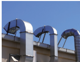
■ 工場のダクト・外装
