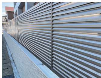
■ 金属製のフェンス・手すり
