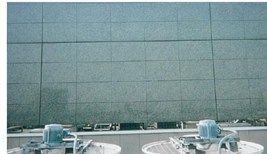
●施工箇所：外壁 ●材質：御影石 ●洗浄剤：ピカソ ●保護剤：ガリレオ
